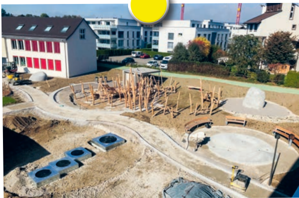
Baufortschritt des Bewegungs- und Begegnungsplatzes in Schwarzenbach
