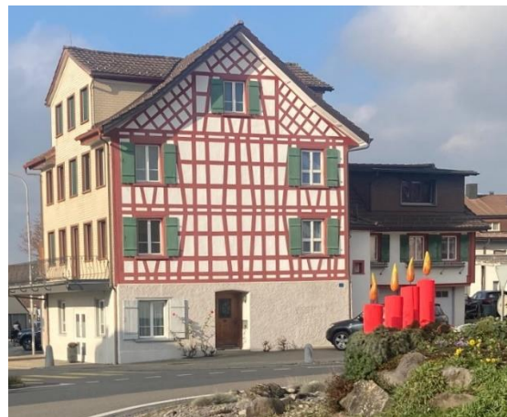
Die ehemalige Schmiede im Jonschwiler Unterdorf
