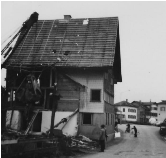
Abbruch der Liegenschaft Hegelbach an der Lütisburgerstrasse im Jahre 1974
